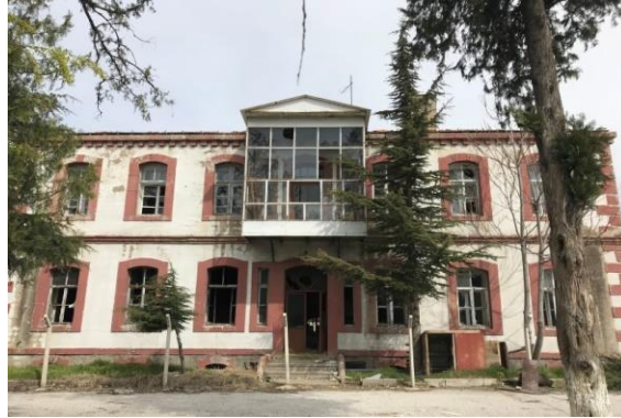
Görsel 8. Çoban Mektebi Merkez Binasının Mevcut Durumu
