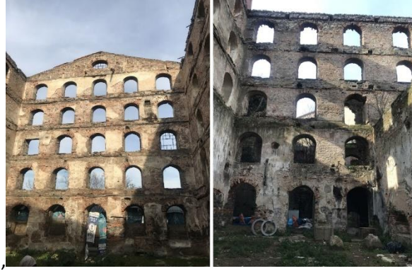
Görsel 4. Paşalimanı Un Fabrikası iç mekân mevcut durumu
