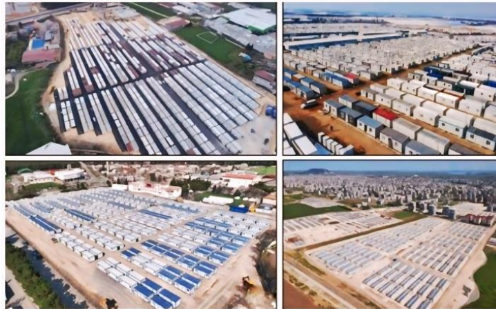
Görsel 4. 6 Şubat'ta Kahramanmaraş depreminin ardından farklı şehirlerde kurulan konteyner kentler
