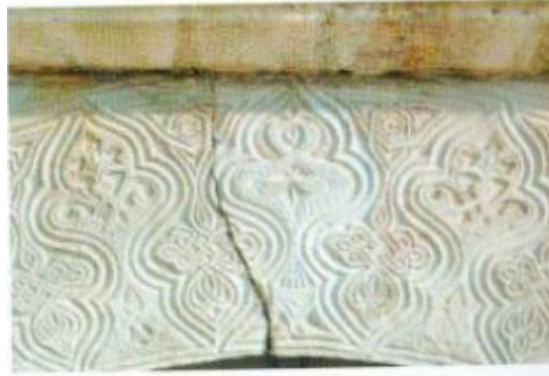
Görsel 32: Meram Hasbey Hamamı Giriş Kapısı Kemer Süslemesi
