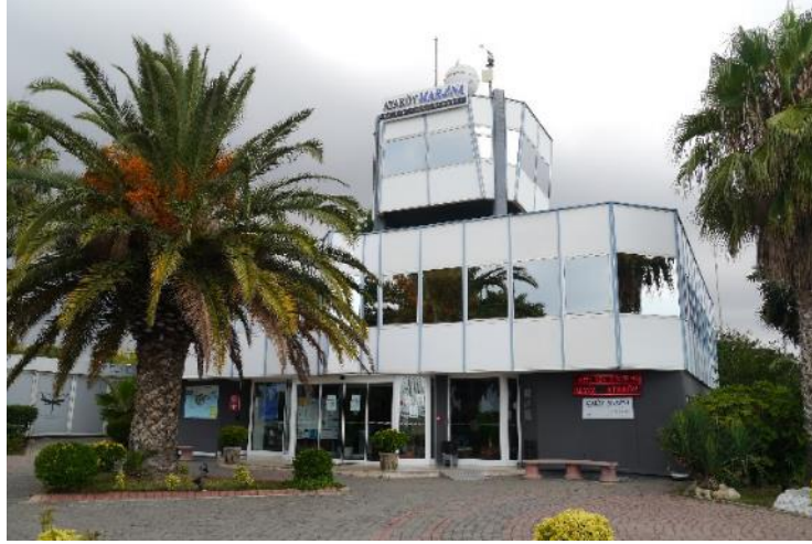
Görsel 4. Ataköy Marina yönetim ofisleri binası.
