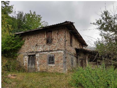
Görsel 12: Ahşap karkas arası dolgu malzemesi olarak harman tuğlası kullanımı (Dağdibi mahallesi)
