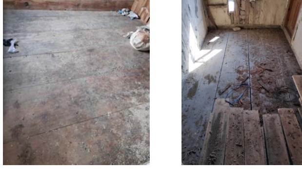
Görsel 23-24: Ahşap kaplama tahtalarıyla döşemenin tamamlanması
