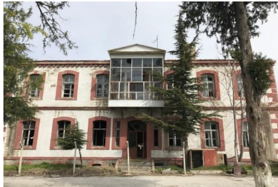
Görsel 8. Çoban Mektebi Merkez Binasının Mevcut Durumu
