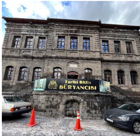
Görsel 3. Tarihi Bitlis Belediye Binası'nın giriş cephesi
