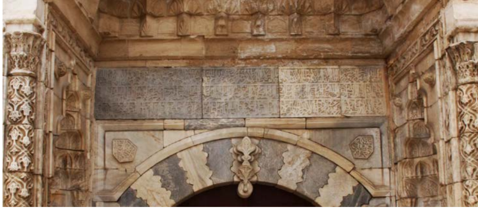
Görsel 8. Medrese Kitabesi ve Portal Detayları
