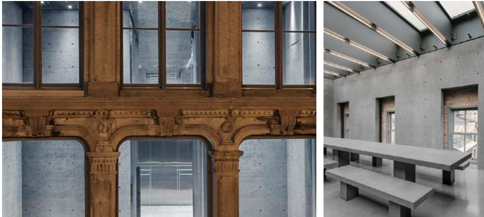
Görsel 6-7. Ssense Montreal Mağazası Cephe Fotoğrafı ve Yapıya Giydirilen İç Kabuk Fotoğrafı
