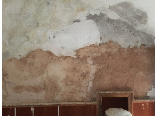
Görsel 21-22. Islak Hacimlerdeki Deformasyon ve Malzeme Kayıpları
