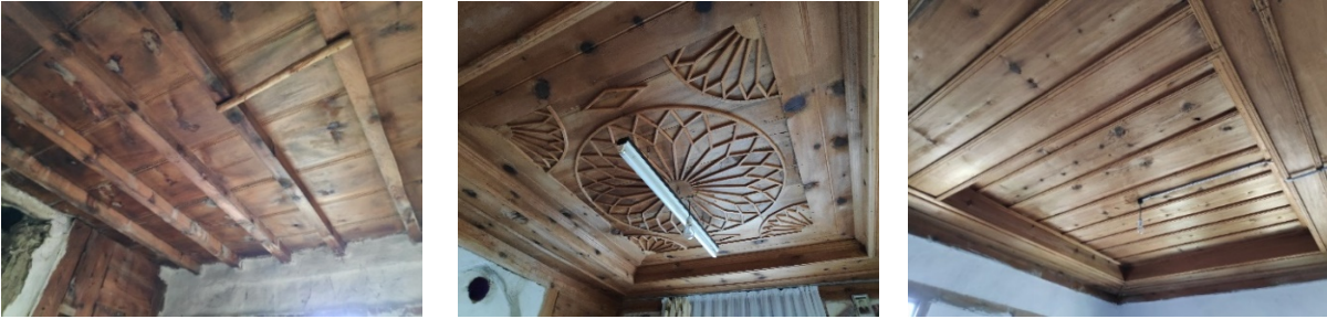
Görsel 25-26-27: Ters tavan, işlemeli (çitakâri) tavan ve çıtalı tavan örnekleri
