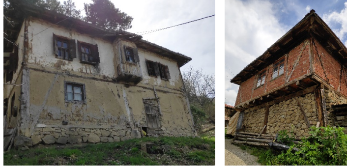
Görsel 29-30: Konsol, kapalı çıkma örnekleri (Berî Güvez ve Yuvalar mahallesi)
