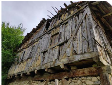
Görsel 22: Döşeme kirişlerinin cepheye yansıması (Dudan mahallesi)
