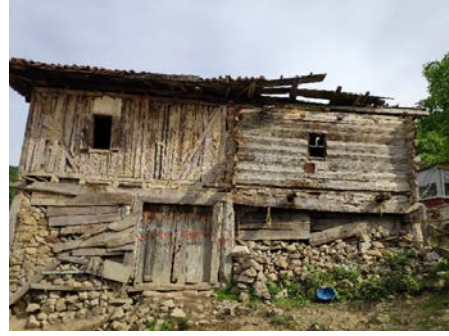
Görsel 13-14: Çantı tekniği kullanılarak inşa edilmiş yapı örnekleri (Alizaim ve Dudan mahallesi)
