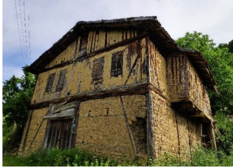
Görsel 11: Hımiş tekniği ile inşa edilmiş duvar örneği (Dudan mahallesi)
