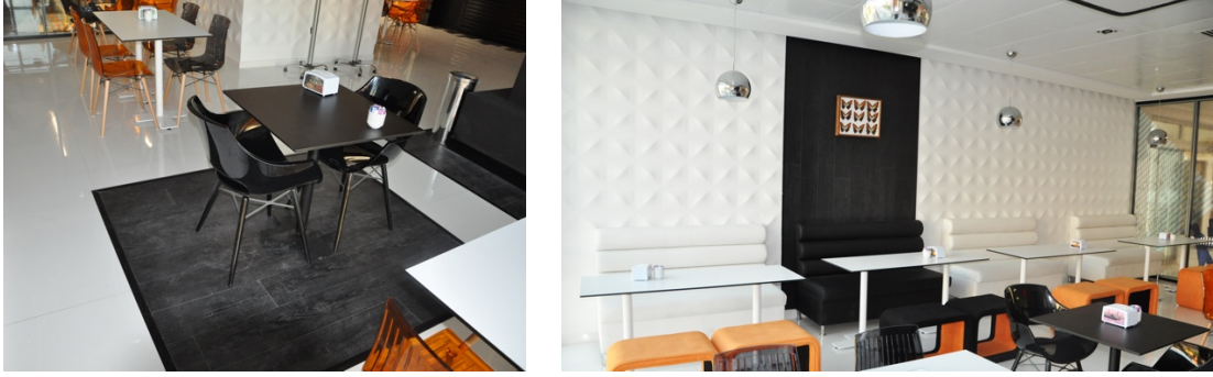
Görsel 16. Kafeterya alanı zemin döşeme ve 3D bambu duvar panelleri
