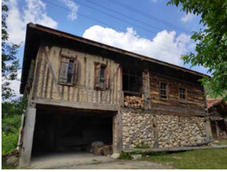
Görsel 13-14: Çantı tekniği kullanılarak inşa edilmiş yapı örnekleri (Alizaim ve Dudan mahallesi)
